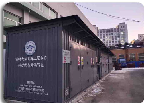
吉林大学汽车工程学院 室外气瓶房（移动式防爆供气柜）
