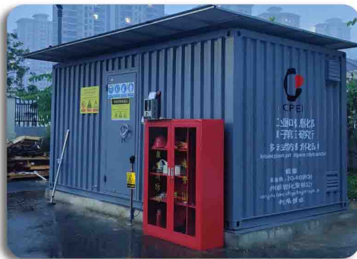
工业和信息化部电子第五研究所 室外危化品暂存库(移动式防爆危化品柜)
